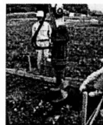
オーガーによる掘削
