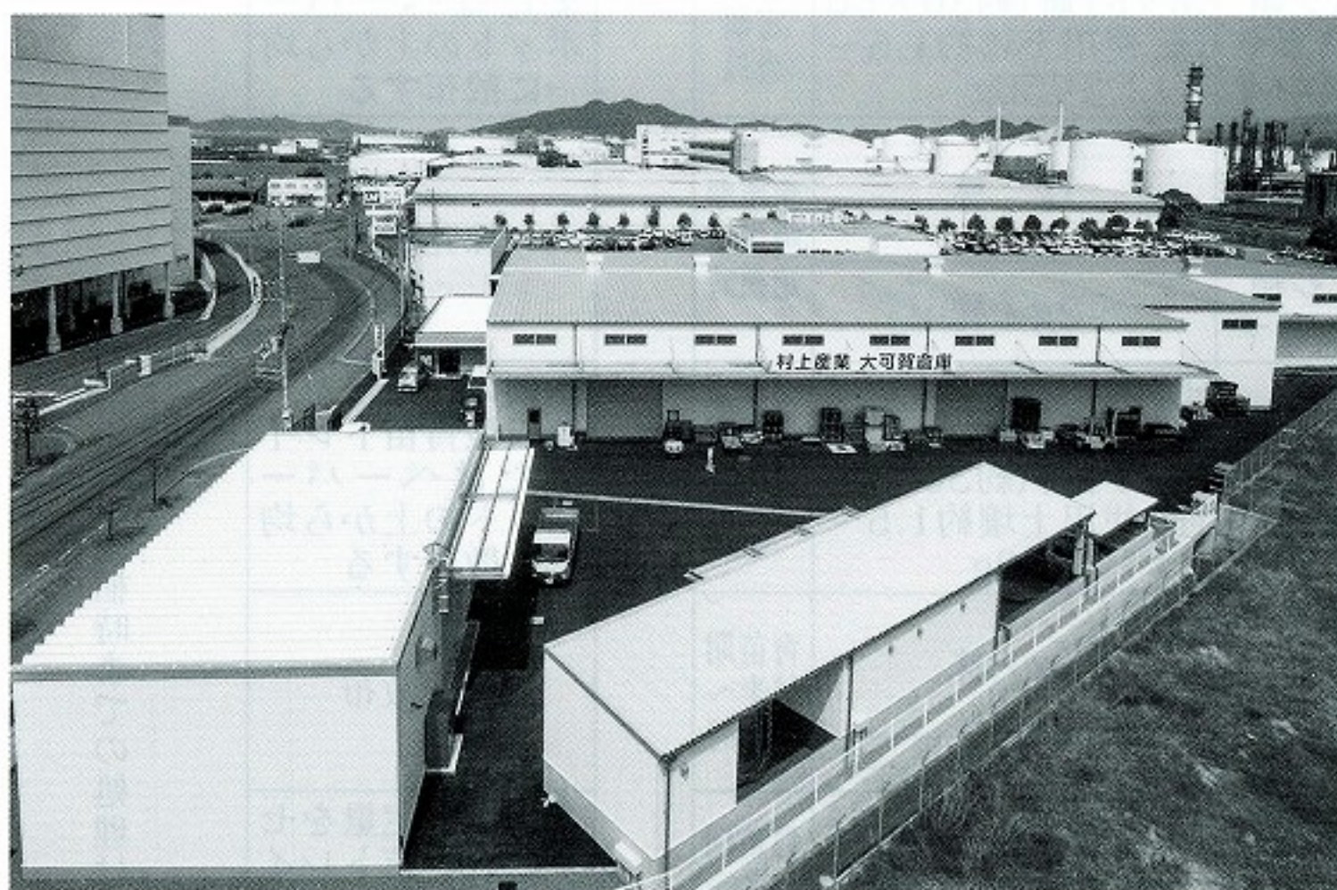
完成した大可賀倉庫
