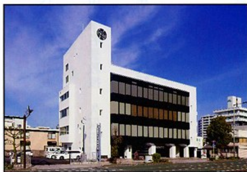
改築後の本社風景
