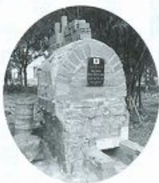
⑥ 吉岡さん作成 『ジェットストーブ式 焼却炉』
