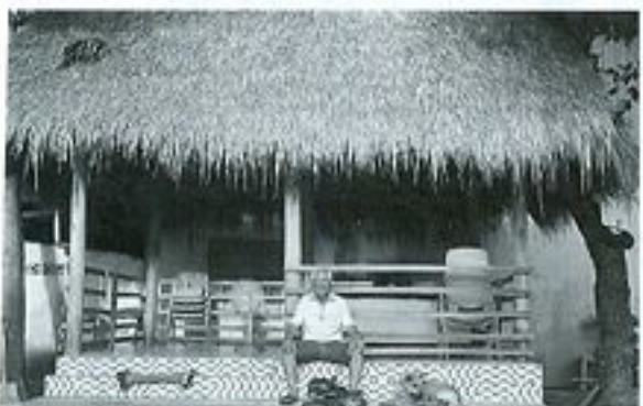
傾いていた東屋を改修
