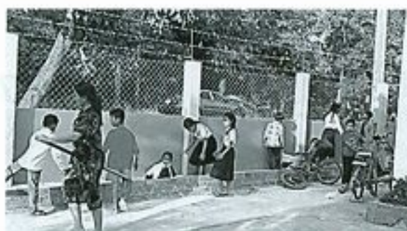
IMCCD日本語学校の外柵が完成
